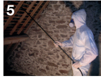
Pulvérisation du produit de traitement de bois D'XYL sur l'intégralité de la charpente
